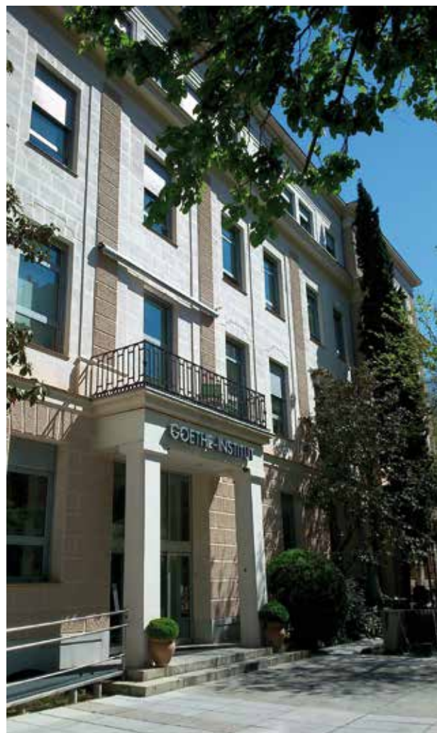
Edificio del antiguo Colegio Alemán en Zurbarán-Fortuny, hoy Goethe Institut. Foto actual de José María Ferrer.
