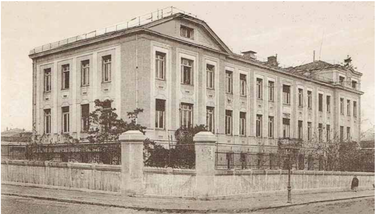
El primitivo Colegio Alemán (hoy Goethe Institut), en la calle Fortuny (sin el piso añadido actual). Postal de las primeras décadas del siglo xx, cedida amablemente por M. a Isabel Gea.
